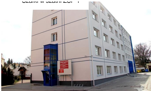
Modernizacja budynku przy ul. Grudziądzkiej 8 (winda do PPP)
